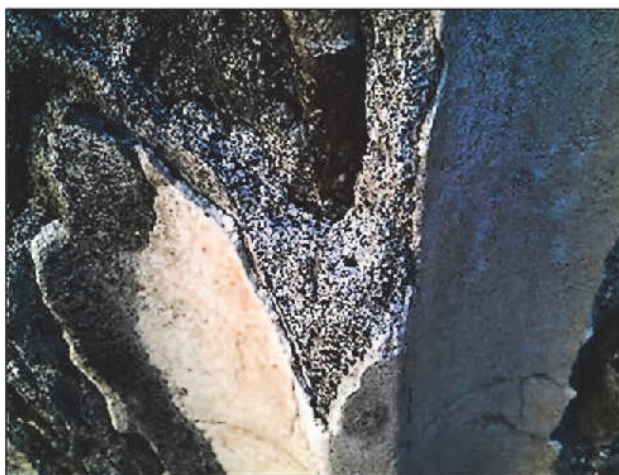
Фото 10. Фрагмент колонны на форуме в Помпеях. Структура построения декоративной штукатурки: подготовительные слои известково-вулканического состава и верхний декоративный слой известково-кальцитного состава с поверхностным уплотнением.
